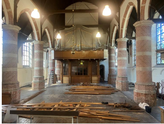
Het orgel is ingepakt, de banken zijn afgevoerd, de plankenvloer is verwijderd en de zerken zijn weggehaald en opgeslagen door de vrijwilligers.
