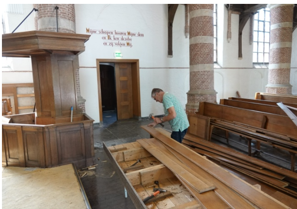
Het verwijderen van de banken
